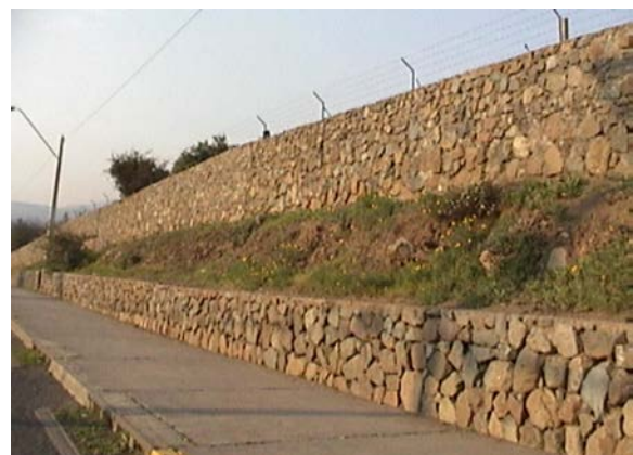
Figura 10: Muro condominio Alboretum.
