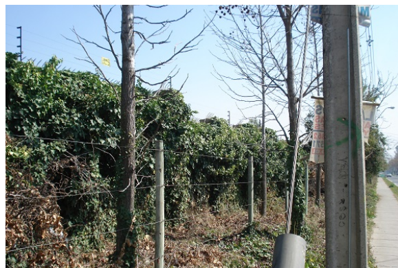
Figura 9: Muro del condominio Casa Grande.
